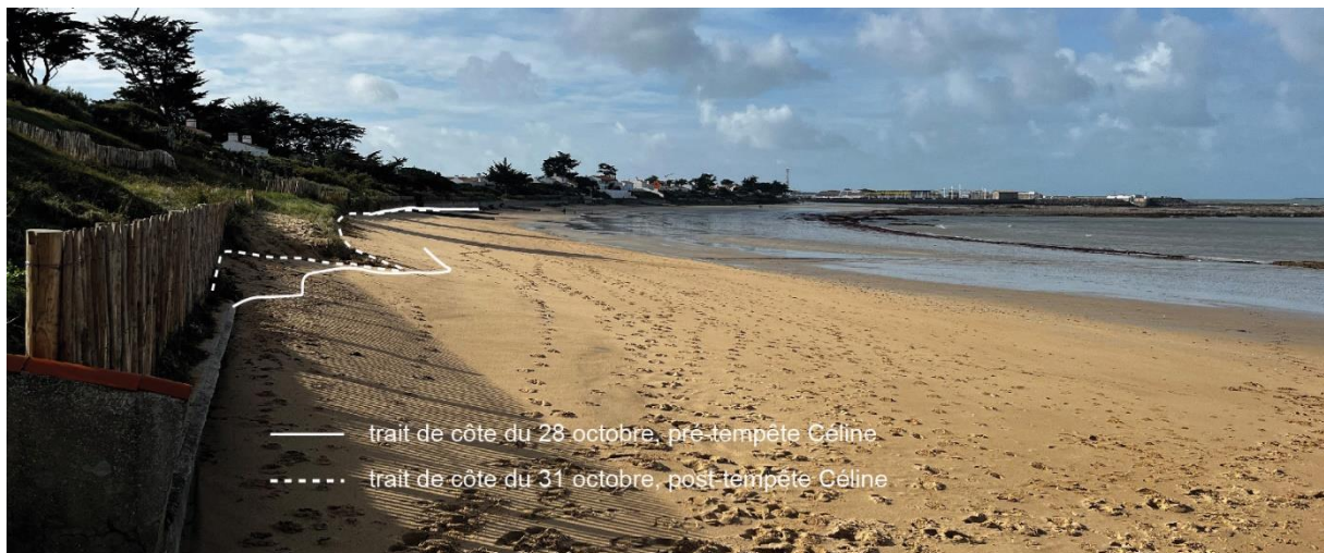
Situation post-tempête Céline, le 31 octobre à 12h32. Le passage de Céline, première tempête automnale, a occasionné un recul au niveau de la dune (premier plan) et un démaigrissement perceptible au second plan au niveau de l'ouvrage transversal.
